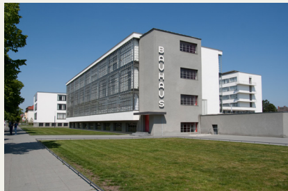
IMAGE NAME: 01_UNESCO_Bauhaus_Bauhausgebäude.jpg
